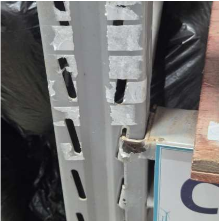
FOTO 025- FIXAÇÃO DAS LONGARINAS EM OXIDAÇÃO E AMASSADAS P05.
