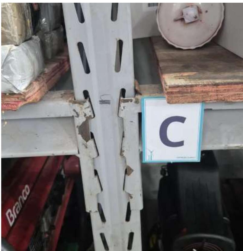
FOTO 023- FIXAÇÃO DAS LONGARINAS EM OXIDAÇÃO E AMASSADAS P03.
