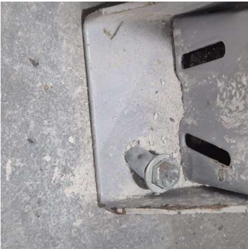
FOTO 025- FIXAÇÃO DAS LONGARINAS EM OXIDAÇÃO E AMASSADAS P05.
