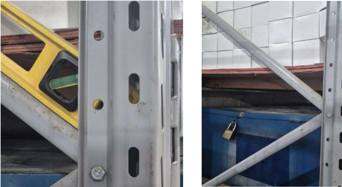
FOTO 006 @ 007 - CONFERENCIA NIVEL TRAVAMENTO DIAGONAL MONTANTE
