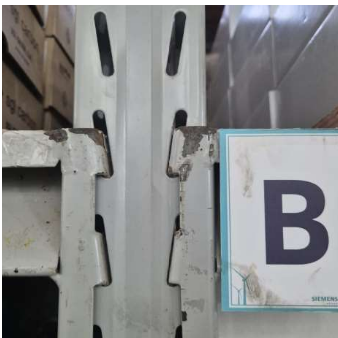
FOTO 022- FIXAÇÃO DAS LONGARINAS EM OXIDAÇÃO E AMASSADAS P02.
