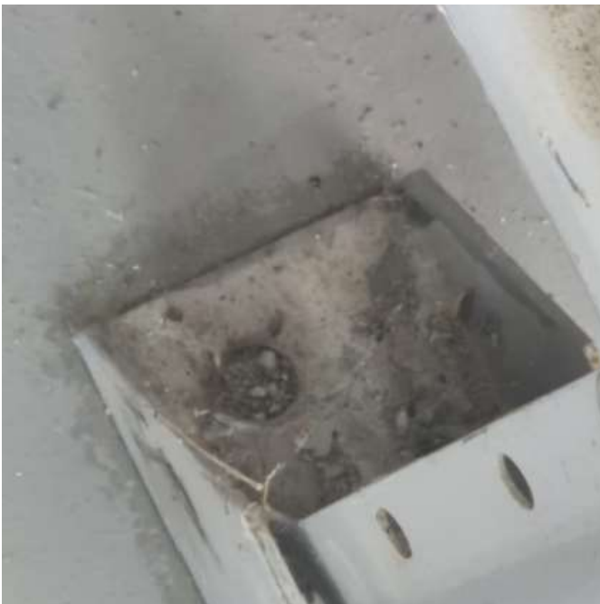
FOTO 012 – REVISÃO E TROCA CHUMBADORES PRATELEIRA D (OXIDAÇÃO DE CHUMBADOR).
