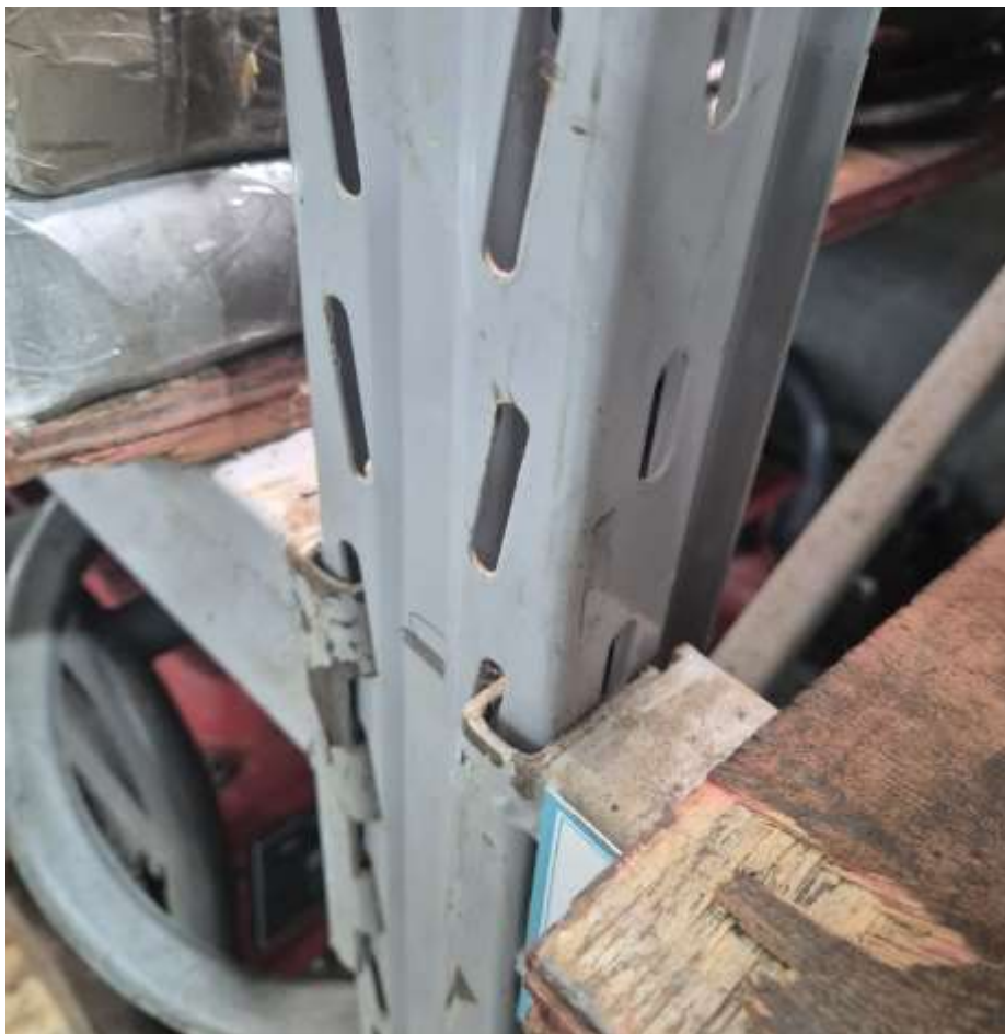
FOTO 009 CONFERENCIA TRAVAMENTO DAS LONGARINAS COM OXIDAÇÃO, ORIENTAMOS A TROCA OU MANUNTENÇÃO DO TRAVAMENTO.
